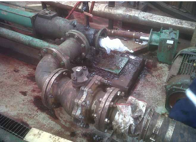
Diseño y Fabricación Piping
