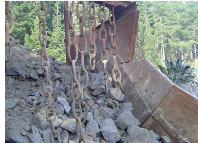
Mantenimiento de chutes de descarga de material
