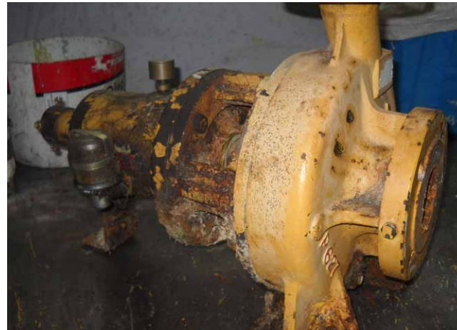
Recuperación, Armado, y Montaje de Bomba
