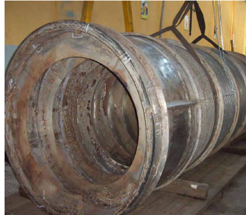
Reparación a Trommel de macerado en zona de mallas y llantas de rotación.
